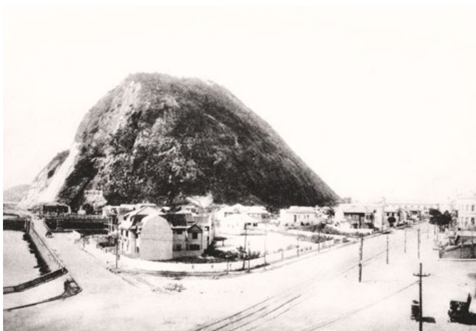
Abertura da Avenida Pasteur, as primeiras construções em área aterrada, acervo Museu Histórico Nacional, Coleção Miguel Calmon
